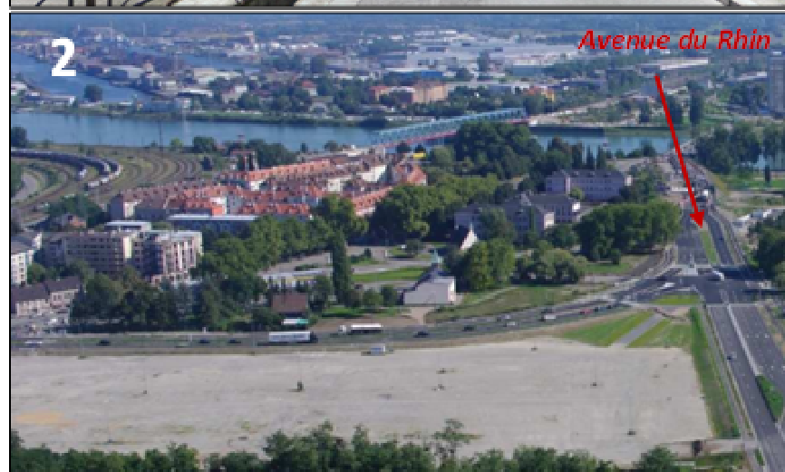
Illustration 43 : Patrimoine bâti et paysager – Secteur Port du Rhin Rue Coulaux (1), Vue d'ensemble du Port du Rhin (2)
