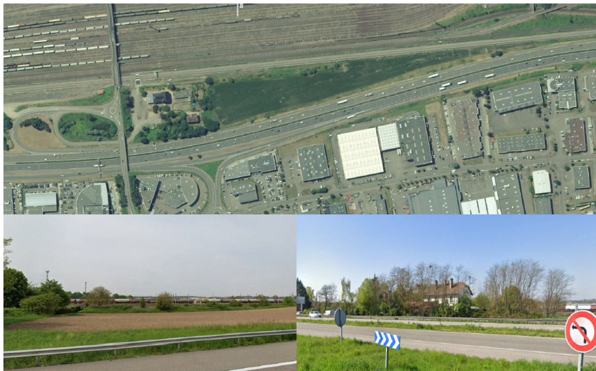
Le site de la " Pointe de la Souffel II " de forme triangulaire, délimité par le faisceau ferré, l'autoroute A 35 et la RM 184. Le site en vue aérienne - en haut - et vu depuis l'A 35 au Nord - en bas - (Source : Google Earth et Google Maps)
