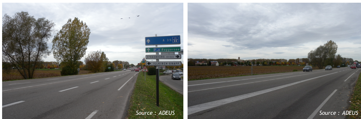
La route RD 468 qui sera requalifiée en voie urbaine (à gauche) Le site d'urbanisation future au Sud de la RD 468 (à droite)
