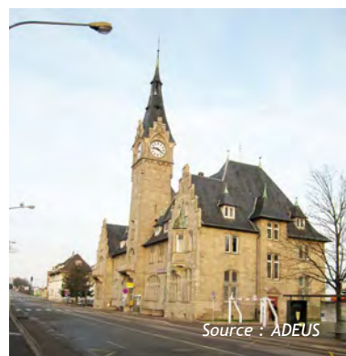
Source : ADEUS L'ancienne capitainerie, rue du Port du Rhin
