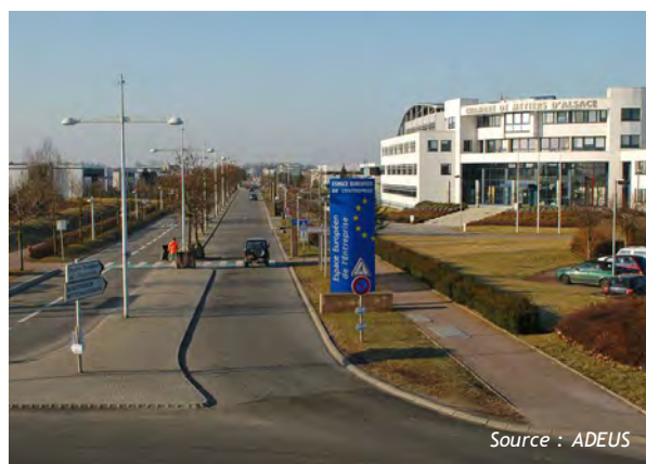
Espace Européen de l'Entreprise, Schiltigheim.
