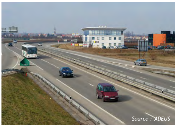
Tissu d'activités se développant le long d'infrastructures routières : ici le long de la RD63 à Wolfisheim (à gauche) et de la RD400 à Entzheim (à droite)
