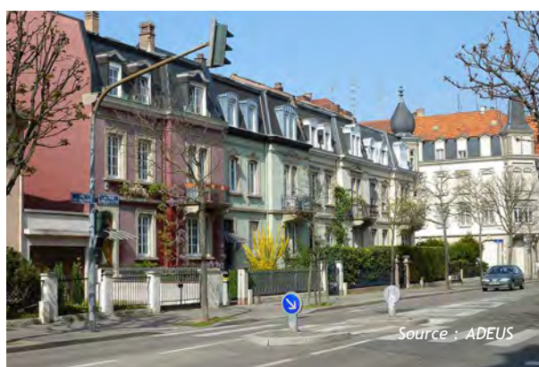
Maisons de ville, av. L. Dacheux, Neudorf
