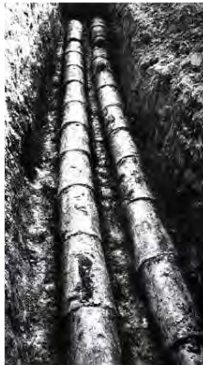
Aqueduc romain reliant Argentoratum à une source d'eau potable de Kuttolsheim. Photo d'une tranchée réalisée entre Dingsheim et Oberhausbergen en 1930. (Source : Archives départementales)
