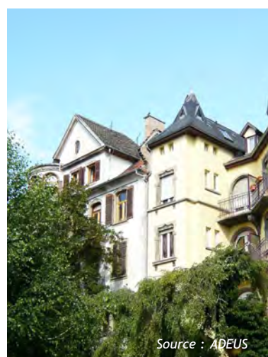
Immeubles XIXe, rue des Foulons
