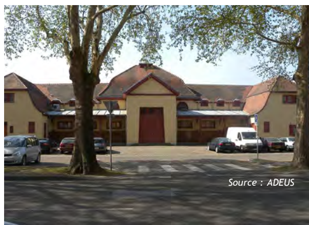
Bâtiment d'entrée du nouveau cimetière juif
