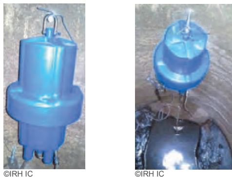
Figure 3 : Exemple d'installation du CFIS au sein d'un réseau d'assainissement
